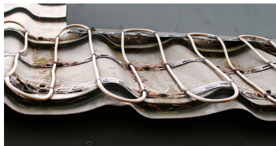
34000003 - vissé sur la surface du toit
